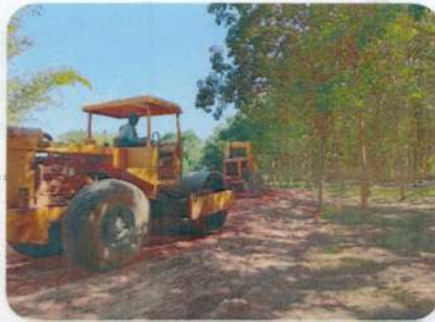
๑ โครงการก่อสร้างถนนลำเลียงการเกษตรซอยศรีสวัสดิ์ เชื่อมบ้านโนนทัน หมู่ที่ ๖ บ้านโนนสมบูรณ์ ผิวจราจรกว้าง ๕.๐๐ เมตร ยาว ๖๕๐ เมตร พร้อมงานวางท่อระบายน้ำ ขนาด ศก. ๐.๘๐x๑.๐๐ เมตร จำนวน ๖ ท่อน
